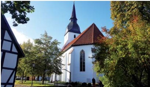
Die historische Doppelkirche in Levern
